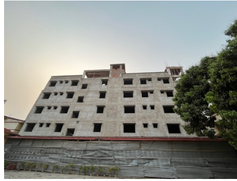
Der Bau im Februar 2023
